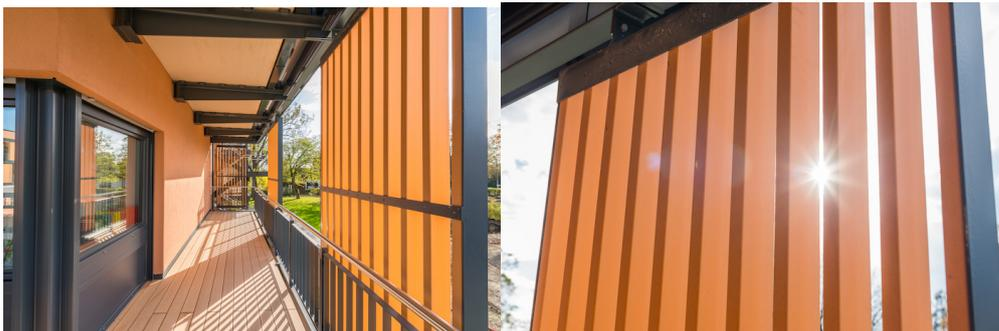
*4-1+-2\_ „Der Konstruktive“ in der Ausführung als Sonnen- und Sichtschutz für das Alten- und Pflegeheim St. Katharina Labouré in Unterhaching. Die massive Lamelle wurde hier auf Stahlrahmen vormontiert und dann an der Fassade angebracht.*
