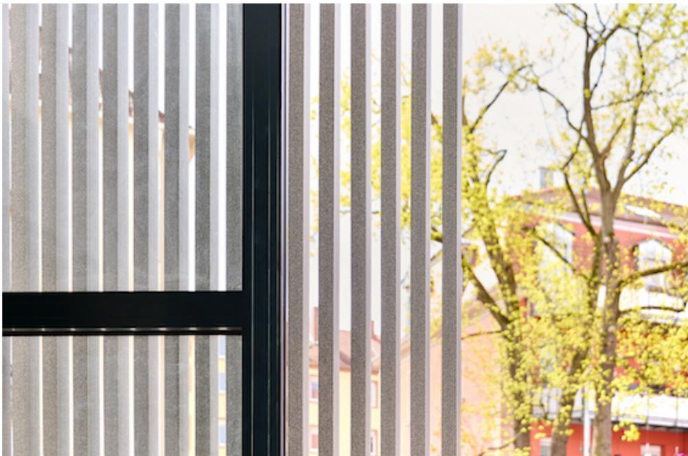
*6\_ Das 2-Kammerprofil der „Linearen“ im Format 40 x 70 Millimeter kann sowohl senkrecht als auch waagrecht auf einen geeigneten Rahmen montiert werden. Bild: studiopfleiderer.de*
